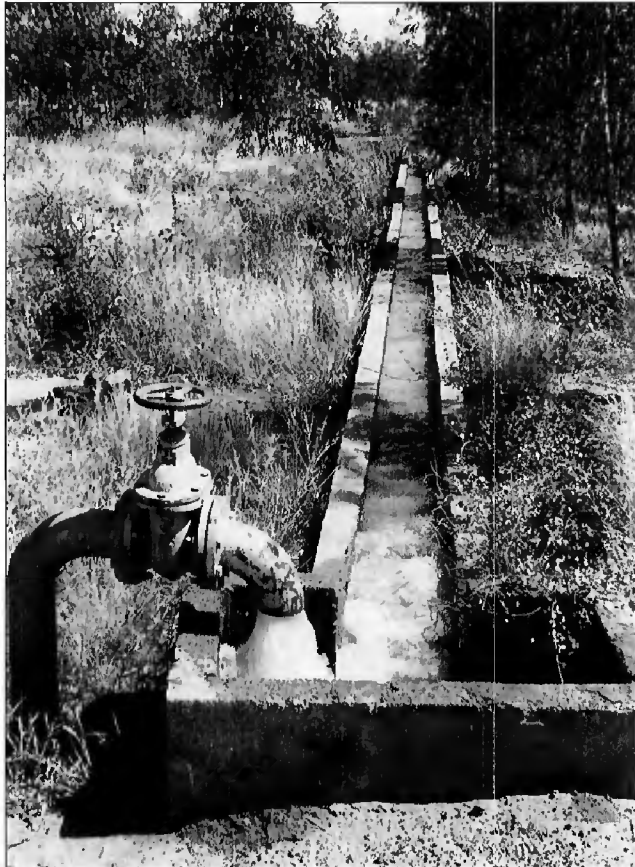
Périmètre au Namardé Goungou. Irrigation gravitaire : distillation de l'eau par carreaux bétonnés. Photo : A. MATYN.
