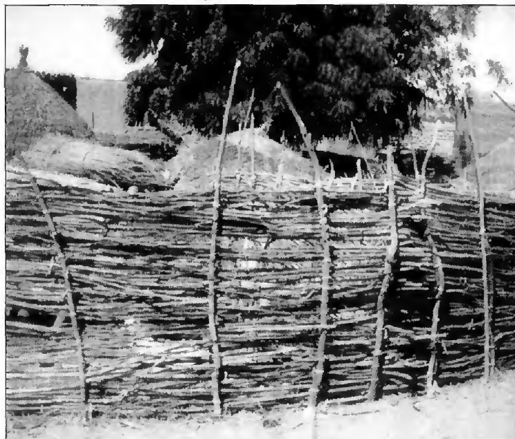
Clôture en branches de moringa, Sarando, Niger. Photo : A. St SAUVEUR.
