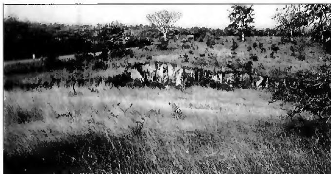
Ravine à 26 km au sud de la ville de Ngaoundéré sur la route de Meiganga, novembre 1997. Ce lavaka menace sérieusement la route Ngaoundéré-Meiganga (arrière plan gauche). Sa tête est déjà à 1 m du bord de la route. Photo : M. TCHOTSOUA.
