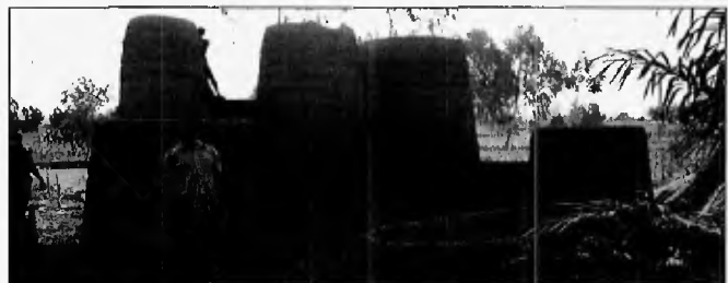
Construction des tours d'un tata (Nadoba, Togo). Photo : C. BONETTI.
