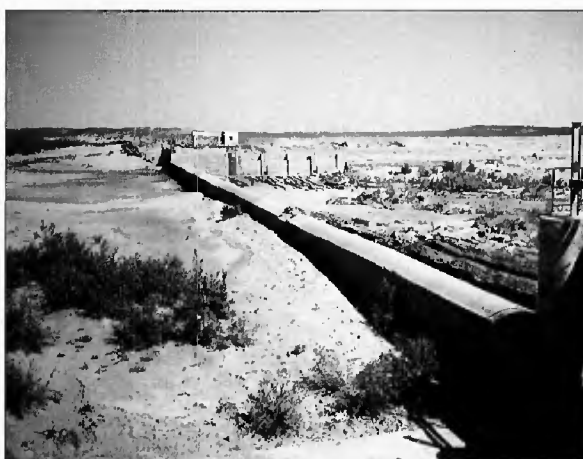
Digue construite sur l'oued Rheris pour freiner les crues, au fond le canal de dérivation, Tafiletet (sud-est marocain). Photo : P. ROGNON.
